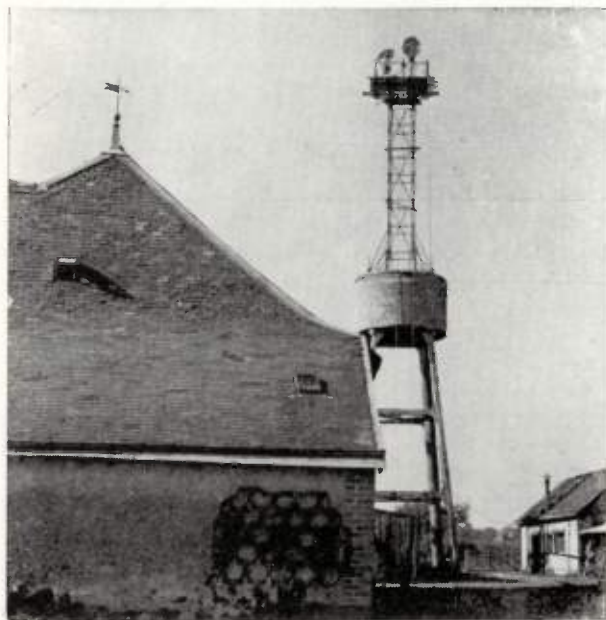
L'un des relais de la liaison temporaire Paris-Tours équipé de matériel mobile TM 110 C.S.F., situé à Saint-Laurent en Gâtines à 30 km de Tours.
