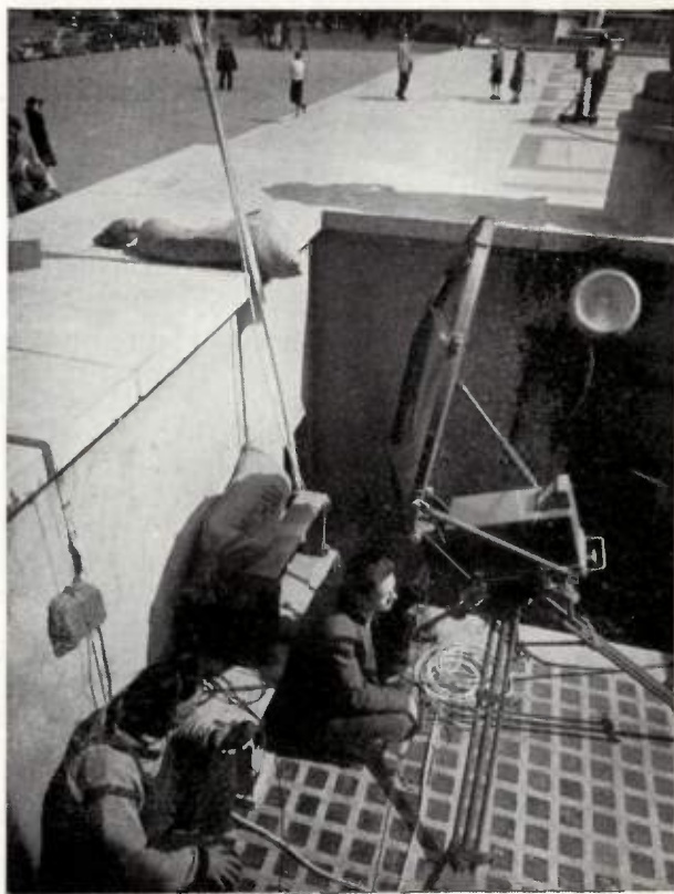
Palais de Chaillot : le dernier relais C.S.F. était installé dans une courrette du parvis où l'on voit l'une des caméras C.F.T.H.
