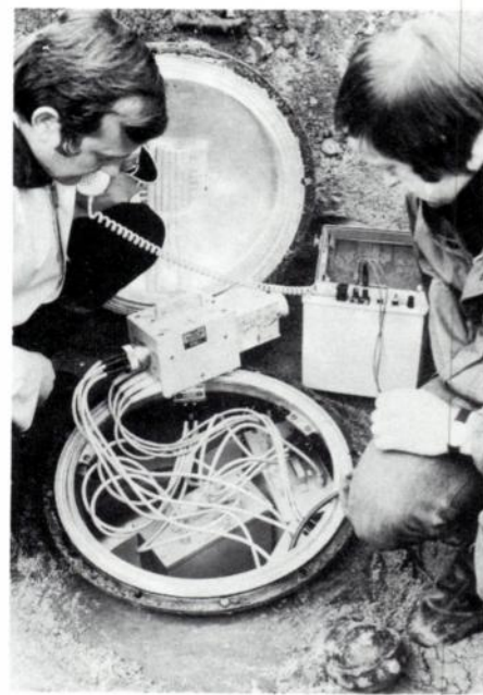
Système à courant porteur de la Deutsche Bundespost « 60 MHz; 10 800 voies » (Document Siemens).
