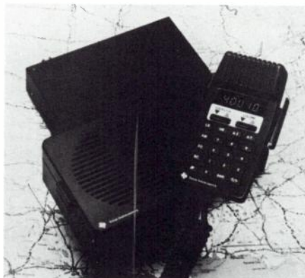
Fig. 2. — Émetteur-récepteur automatique pour services radio-électriques privés mobiles dans la bande des 27 MHz récemment introduit par Texas Instruments (recherche automatique de canaux, affichage permanent du TOS, etc...).
