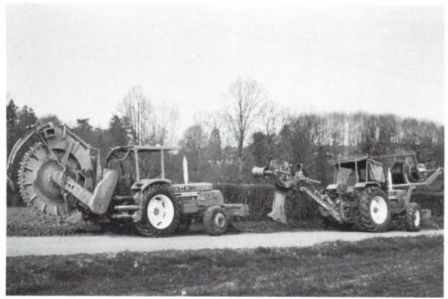
Fig. 3. — Engins pour la pose en pleine terre (tronçonneuse) (lame vibrante).
