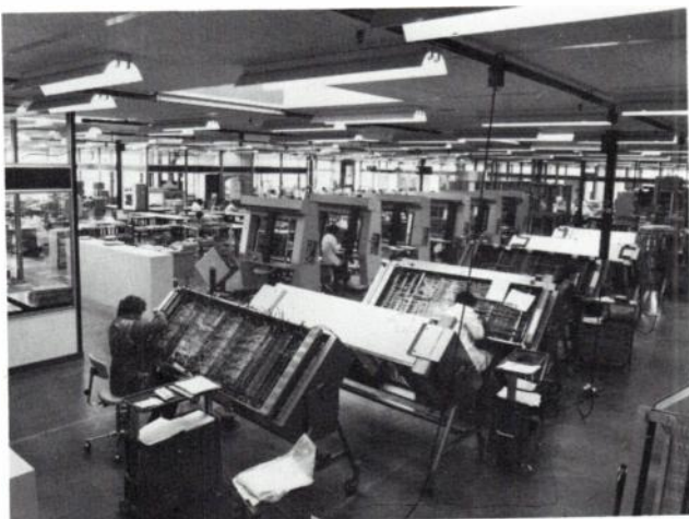
Fig. 15. — Câblage des bâtis à l'usine de Treguier.
