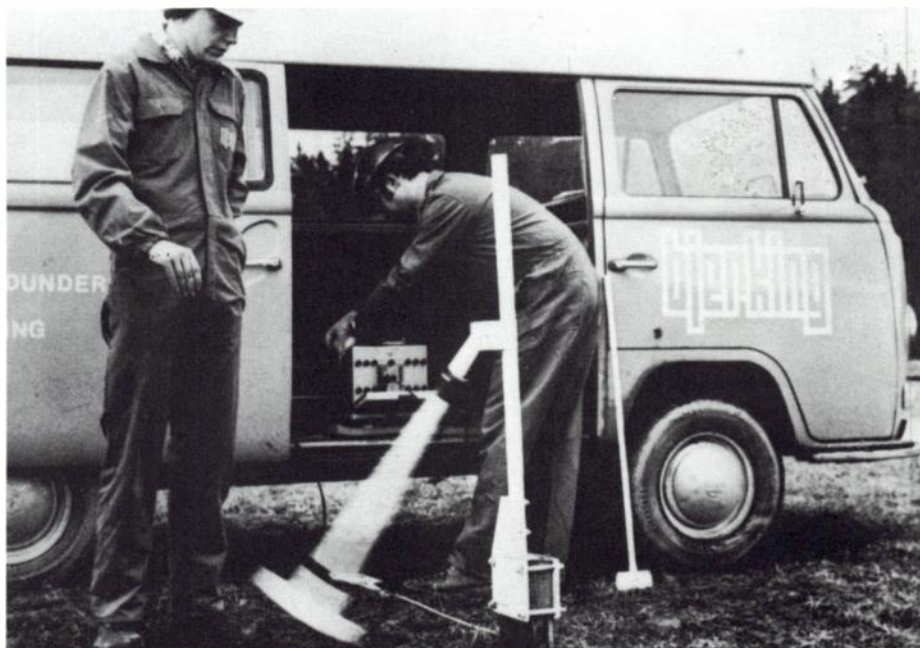
Séismographe à réflexion Atlas Copco, modèle ABEM TRIO.
