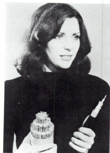
Câble à filtres optiques (à droite) comparé à un câble à 1200 paires métalliques (à gauche).
