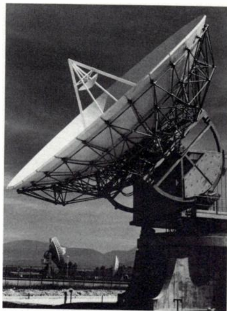
Terminal d'OTS (Satellite d'essais orbitaux) à la station de Fucino (Italie). L'antenne mesure 17 m de diamètre.
