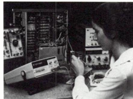
— Compteur-fréquence-mètre-périodemètre-intervallomètre à 7 chiffres (0-100 MHz), modèle PH 5314 A. [9973]
