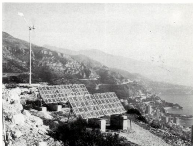
Fig. 1. — Station mixte expérimentale utilisant les énergies solaire et éolienne et dont l'implantation a été décidée par M. A. G. Pluchard, chargé du Département Assistance Technique.
