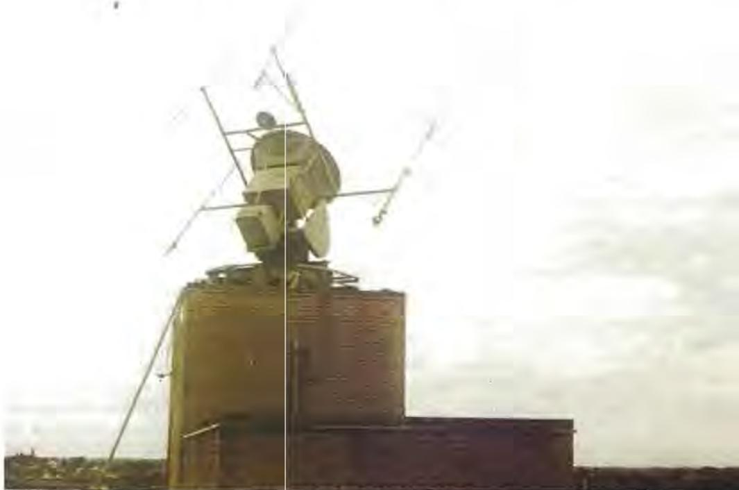
*Le bloc des antennes de contrôle et de réception. Le suivi est soit automatique, soit manuel.*
