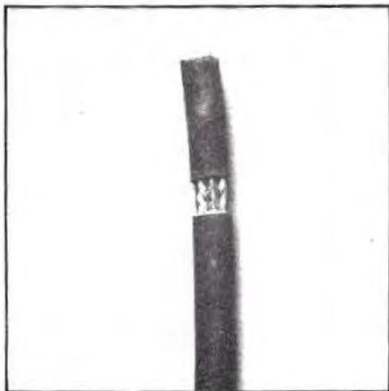
1. A l'aide d'un cutter, coupez la gaine isolante extérieure en prenant garde à ne pas abîmer la tresse.
