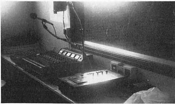
Photo n° 2 — Vue partielle de la cabine. Sur la table on aperçoit de gauche à droite : le pupitre des correcteurs paramétriques, le pupitre de prémélange des micros, le pupitre de diffusion, un magnétophone à cassettes. En haut,
