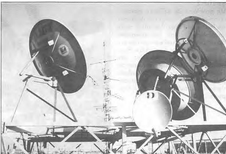
Le centre d'émission national (centre de connexion), installé dans la région de Troyes, près de Bercenay-en-Othe, utilisera une antenne de 8 mètres de diamètre émettant dans un pinceau de  $0,15^\circ$  d'ouverture en direction du satellite. Il assurera en outre les liaisons indispensables au maintien en altitude et en orbite du satellite sur ordre du centre de contrôle du CNES implanté à Toulouse.
