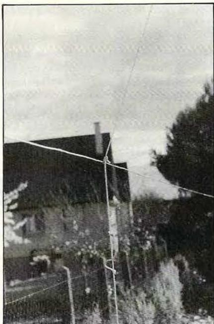
La base du triangle est maintenue à 8,90 m par la ficelle, le bout pendant indiquant la hauteur.
