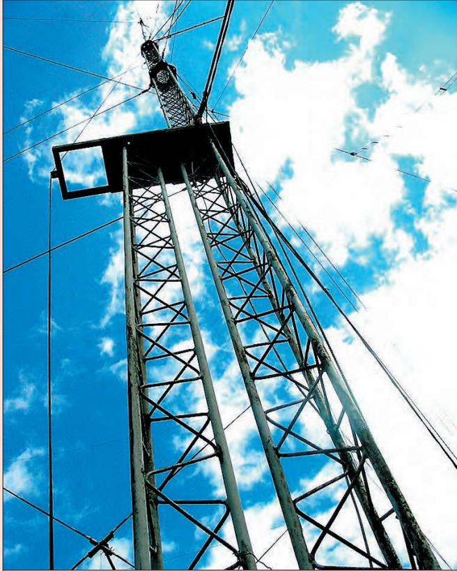
2 - La solution retenue chez F5MPW : un pylône à la base prolongé ensuite par un mât jusqu'à 17 m.
