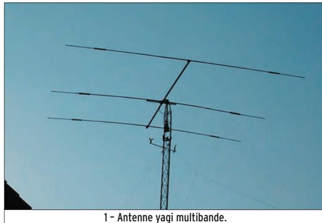
1 - Antenne yagi multibande.
