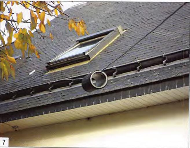
L'effet capacitif avec le brin annule une partie de la longueur repliée. L'avantage est de pouvoir revenir en arrière sans ajouter de fil si l'accord est trop haut en fréquence.
