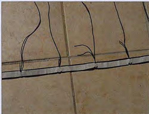
6 - Vue la boucle de finition avant mise sous tension.
