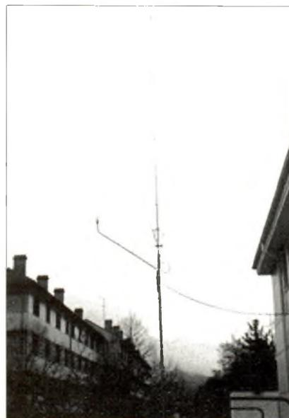
L'antenne CB et la discône sur le bras de départ.
