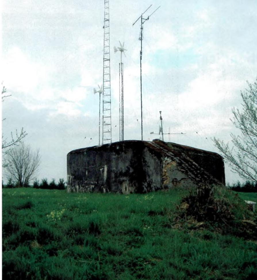
**Quatre années se sont écoulées et le vent ne cesse de faire tourner les deux éoliennes. Dame nature est généreuse, la station radioamateur F5IVX en portable bénéficie d'une énergie non polluante et suffisante pour assurer le trafic radio ainsi que les besoins domestiques lors des week-ends.**
