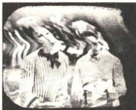
Fig. 6 - Una lampada al neon di una insegna pubblicitaria di un bar, riusciva ad incidere tanto sulle immagini, da deformarle nella maniera grottesca che mostra la foto.
