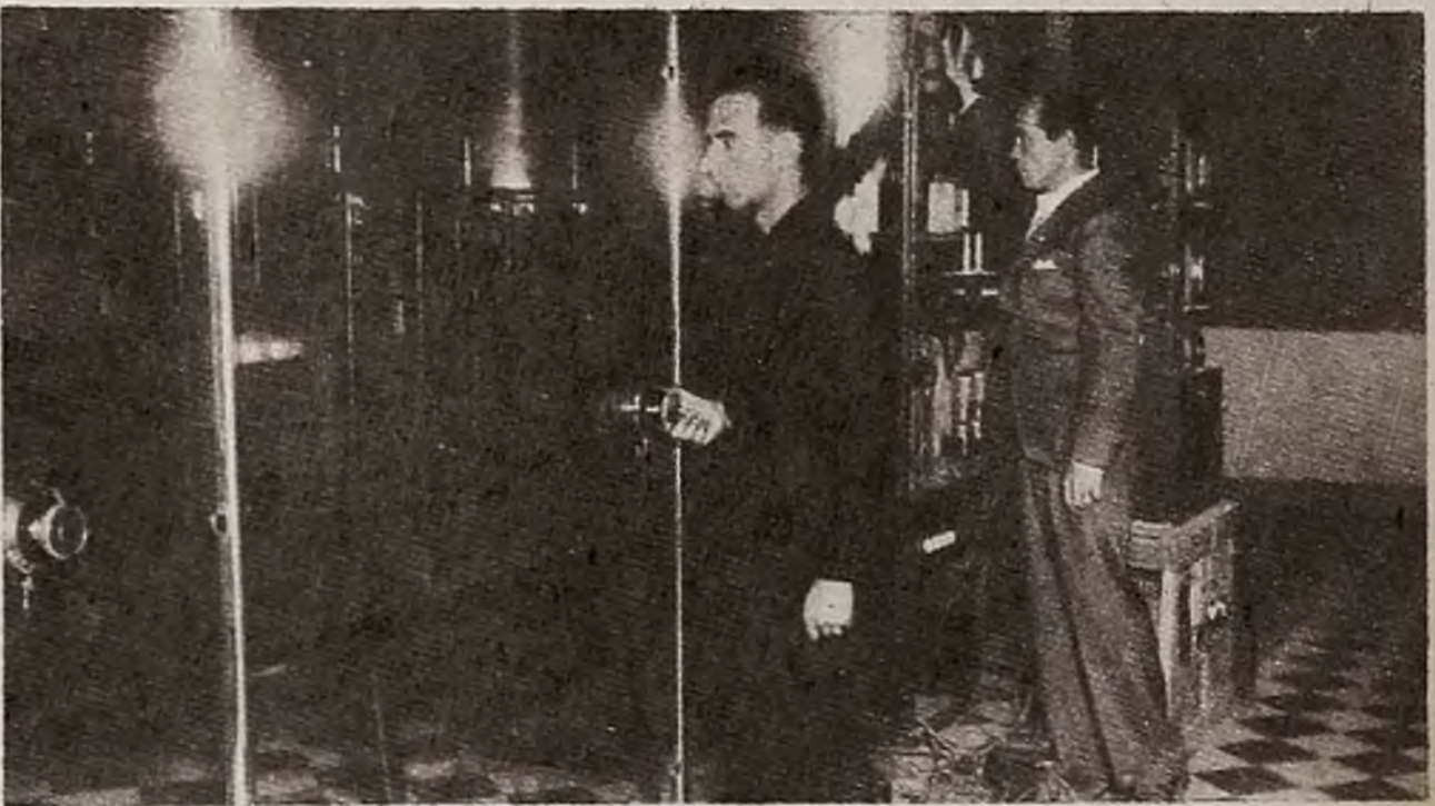
Una de las operaciones comunes a todos los días. El encendido del transmisor: uno de los operadores retoca la etapa intermedia, mientras el otro regula la excitación del alto voltaje.
