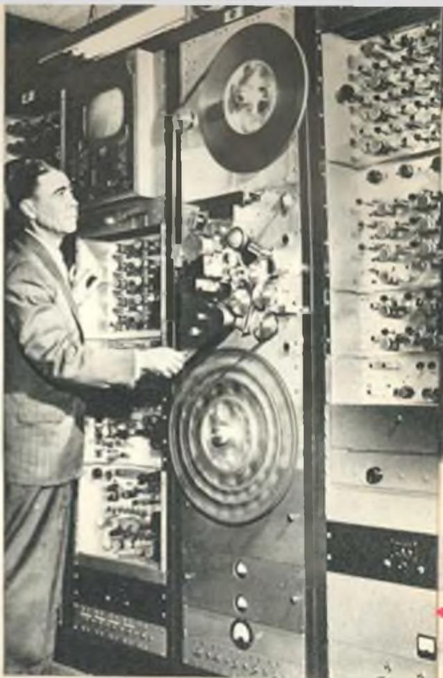
IL SISTEMA R.C.A. adopera matrici magnetiche di incisione e riproduzione fra bobine su questo quadro. Sono sufficienti 33 secondi per innestare e sintonizzare questo meccanismo di precisione ad alta velocità.
