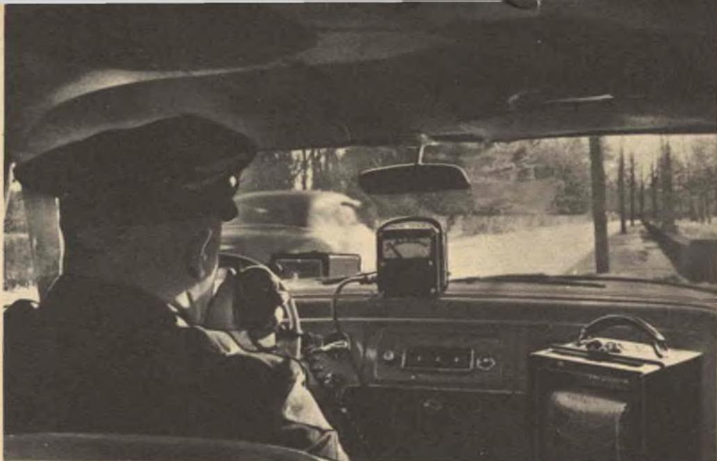
La maggior parte degli agenti americani della polizia stradale monta il misuratore radar di velocità su treppiede. Cavi di connessione permettono all'agente di eseguire le misure della velocità sia in macchina che fuori. Quando è dentro l'automobile, esso è generalmente in comunicazione con un collega che si trova circa 1-2 Km. più avanti, sulla via.
