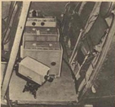
**LA TELECAMERA**, installata nell'elicottero, fornisce una visione generale del traffico durante un esperimento svolto con successo in Inghilterra. La telecamera e il trasmettitore sono disposti per comodità nella fusoliera, ma in modo tale che l'obiettivo possa avere una visuale sufficientemente ampia dall'apertura laterale dell'elicottero. La foto a sin. mostra l'antenna trasmittente montata sulla coda dell'elicottero.
