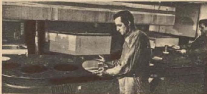
Un nastro trasportatore convoglia i dischi vergini attraverso le operazioni di ricoprimento e di essiccamento a temperatura e umidità rigidamente controllate. A SINISTRA nella foto viene applicato la lacca. Poi i dischi vengono posti su rastrelliere e immagazzinati. A DESTRA. Per ultimo viene eseguita una accurata ispezione e numerazione. Dopodiché i dischi sono quindi punzonati ed etichettati.
