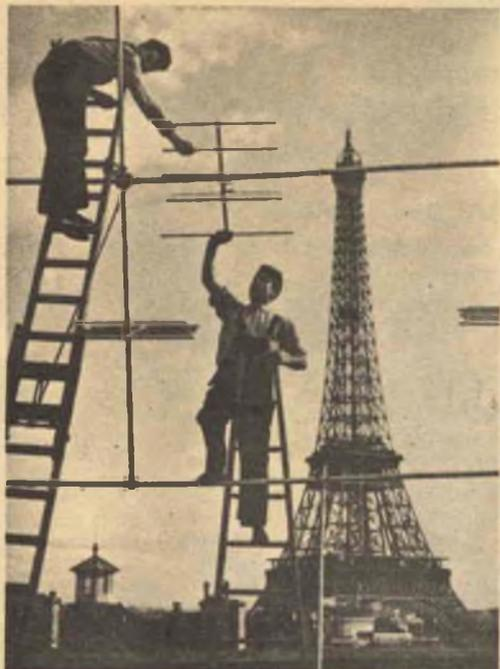
Due tecnici stanno montando sul tetto di una casa nei pressi della Torre Eiffel, alcune antenne per televisione. Sono le antenne che permetteranno agli 80 ricevitori, funzionanti simultaneamente in un vicino Salone d'Esposizione, di captare le onde emesse dalla Torre Eiffel.
