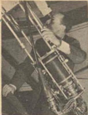
La telecamera fotografa immagini che mettono in rilievo particolari del disco solare in ultra-violetto e infra-rosso. La tecnica elettronica si è rivelata superiore a quella fotografica nell'eliminare gli effetti dell'oscillazione atmosferica.
