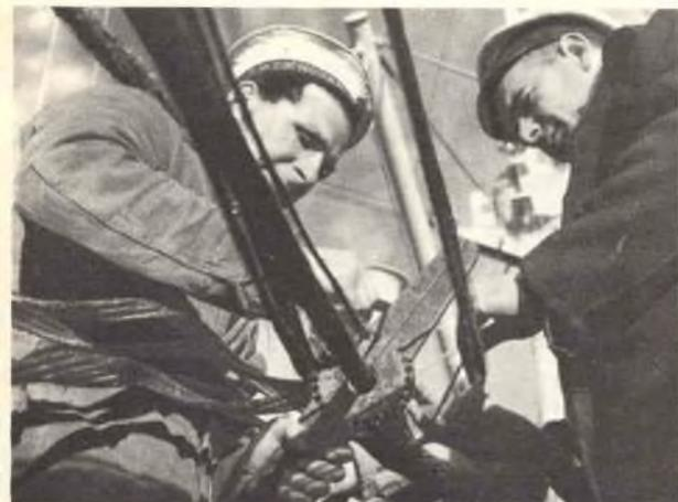
In fotografia si vedano due tecnici intenti ad impiantare la parte terminale del cavo che, attraverso 2.300 miglia di oceano, collega la Scozia con Terranova. L'impiantatura, che richiede diverse ore di lavoro, viene poi collaudata per mezzo dei raggi X.
