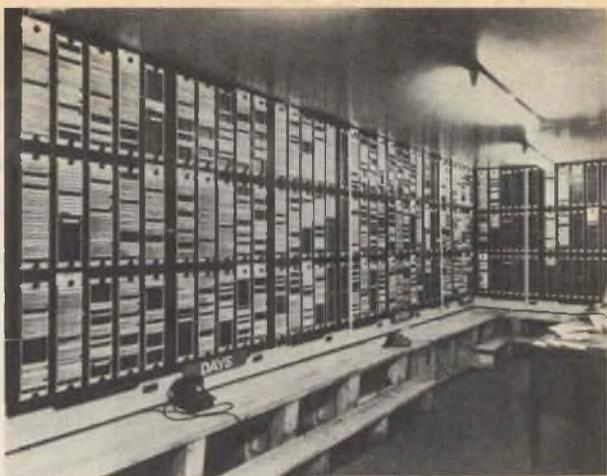
**Un economico sistema di posizione** - Per soddisfare la richiesta di un sistema di posizione di media precisione e di basso costo è stata costruita dalla Associated Electrical Industries Ltd. un'apparecchiatura numerica con predisposizione a coordinate per macchine utensili. La precisione dichiarata dal costruttore per questa apparecchiatura è di 0,0254 mm.
