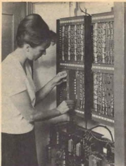
Nella fotografia è visibile il montaggio di un modulo di conteggio nell'unità centrale del sistema di controllo a stato solido Tectorstat.
