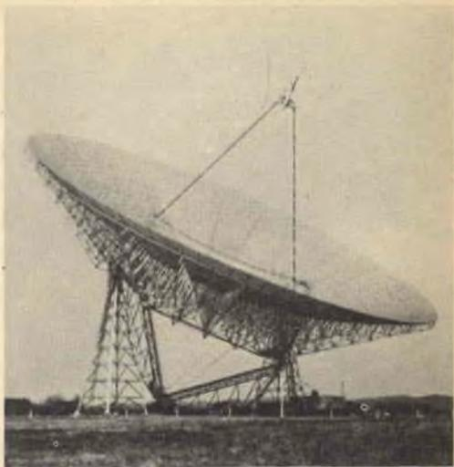
Ecco il grande telescopio da 90 m implantato nel National Radio Astronomy Observatory in Virginia. Si tratta della più grande unità, parzialmente manovrabile, finora installata. Di solito questo telescopio è impiegato per la misura di idrogeno nella nostra galassia ed in quelle vicine.
