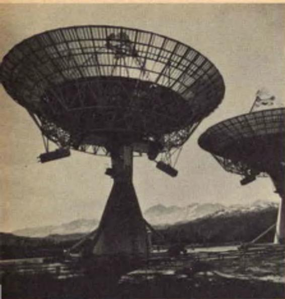
Nell'Owens Valley Observatory, in California, due dischi del diametro di 27 m operano insieme come un interferometro; essi possono distanziarsi fra loro fino a 0,5 km circa scorrendo su rotaie, ed anche funzionare indipendentemente l'uno dall'altro. Questa installazione, operando su 960 MHz, viene spesso usata per tracciare un grafico rappresentante la distribuzione dei disturbi radio presenti nella nostra galassia.
