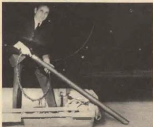
**Un tecnico esamina uno dei quattro anodi di carbone disposti, in acqua, intorno allo scafo di acciaio. Gli anodi, caricati con corrente continua uguale a quella da annullare, eliminano l'azione elettrolitica determinata dal flusso della corrente.**
