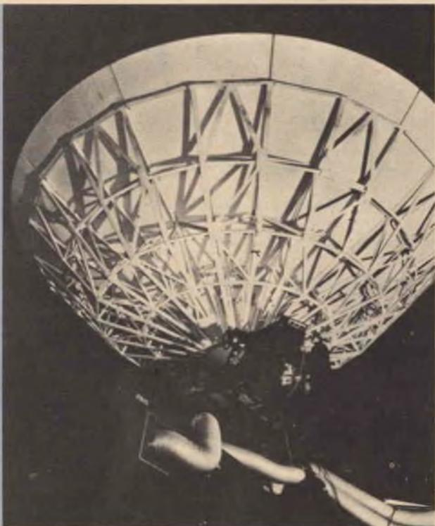
adattabili su satelliti e faranno parte di un progetto sviluppato in unione con le autorità militari americane e che prevede il lancio da parte degli Stati Uniti di una serie di satelliti quasi sincroni. L'antenna a disco è stata costruita all'interno di una cupola gonfiabile del diametro di 21 m, che serviva a proteggere l'equipaggiamento dagli agenti atmosferici.
