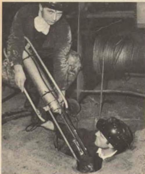
troppo piccoli per consentire ad un uomo di introdursi in essi. Una speciale telecamera viene introdotta nelle fognature e lo schermo televisivo riceve e riproduce ogni rottura o difetto che si verifichi nei canali di scarico.
