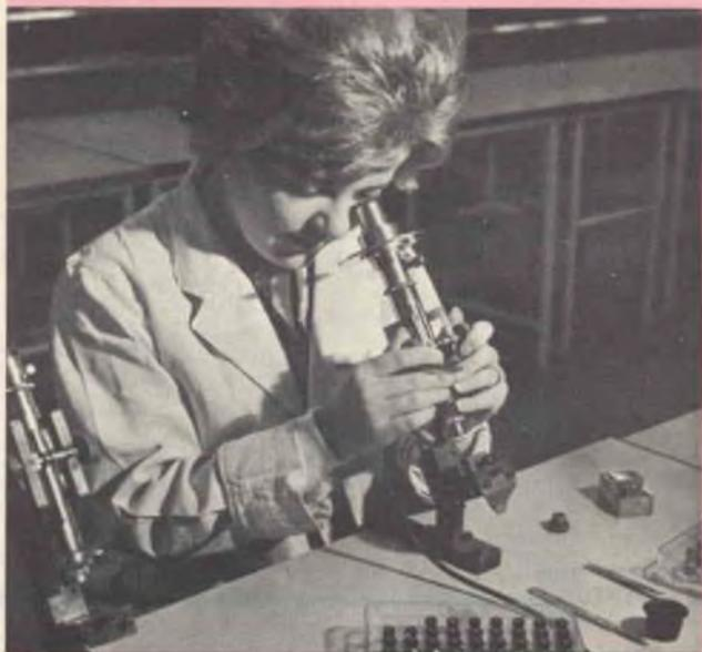
**I**a fotografia illustra come vengono controllate, secondo la tecnica più recente, le testine di registrazione per tamburi magnetici presso i laboratori della Standard Telephones and Cables Ltd. I materiali magnetici vengono forniti per l'uso in apparecchiature destinate alle trasmissioni a lunga distanza, alle comunicazioni telefoniche, alla trasmissione di segnali telegrafici e televisivi; detti materiali, inoltre, sono usati in trasformatori di corrente ed in amplificatori magnetici.
