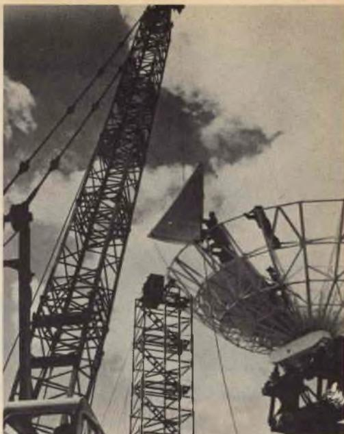
Alcuni tecnici sono intenti ad installare i pannelli dell'antenna destinata alla stazione terrestre per satelliti dell'isola di Ascensione.
