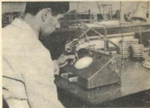
effettuato toccando ognuna delle colonie con una sonda elettronica. Con questo metodo vengono evitati gli eventuali doppi conteggi, permettendo che il numero totale delle colonie contate sia registrato sul contatore numerico.
