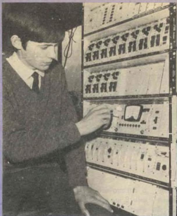
Nella foto si vede un tecnico della G.E.C. di Coventry in Inghilterra intento a regolare un'apparecchiatura telefonica di trasmissione a dodici circuiti, ordinata dal ministero delle Poste e Telegrafi norvegese. L'apparecchiatura, interamente transistorizzata ed in grado di portare dodici conversazioni telefoniche, sarà impiegata per potenziare l'attuale sistema di telecomunicazioni norvegese. In tutto la ditta inglese G.E.C. fornirà ventiquattro stazioni terminali e cinque stazioni ripetitrici.
