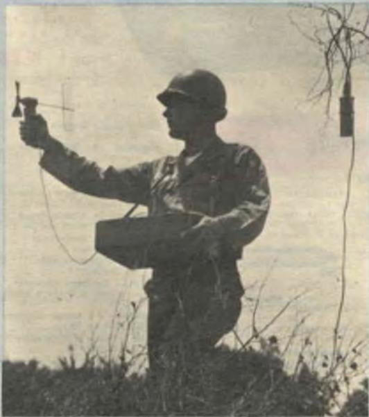
Con la sua alta precisione nel misurare le principali variabili meteorologiche, la stazione AN/TMQ-22, illustrata nella foto e costruita per l'Esercito degli Stati Uniti dalla Cambridge Systems Inc., viene ritenuta la più perfezionata unità meteorologica da campo portatile del momento. Un uomo da solo ha la possibilità di metterla in funzione in meno di cinque minuti.
