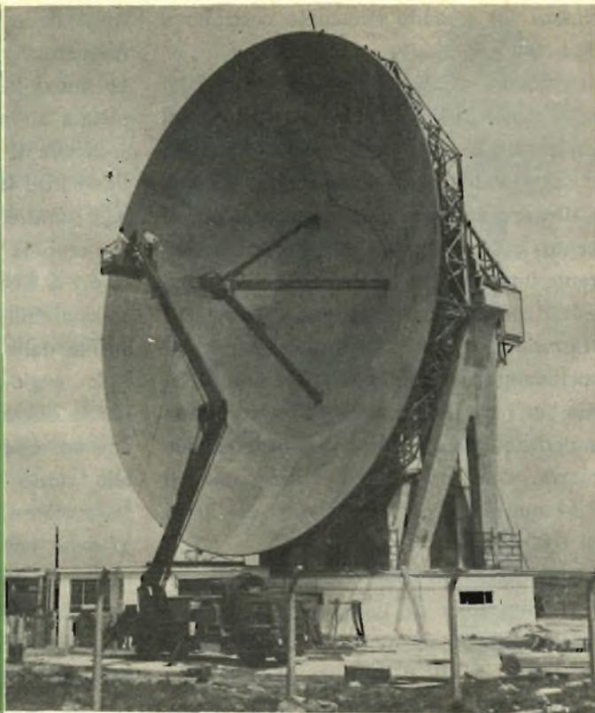
Per ottenere un'alta efficienza nella trasmissione del segnale, la stazione a terra deve avere una grande antenna a forma di catino, realizzata con estrema precisione ed azionata da motori che la tengano continuamente puntata sul satellite.
