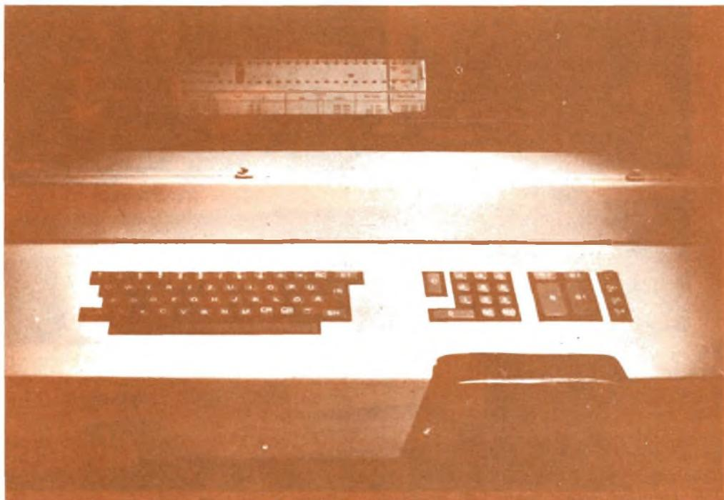
**La tastiera dell'elaboratore P 350 è composta da una tastiera convenzionale da macchina da scrivere per i dati alfanumerici e da una tastiera numerica internazionale a 10 tasti per i dati numerici.**
