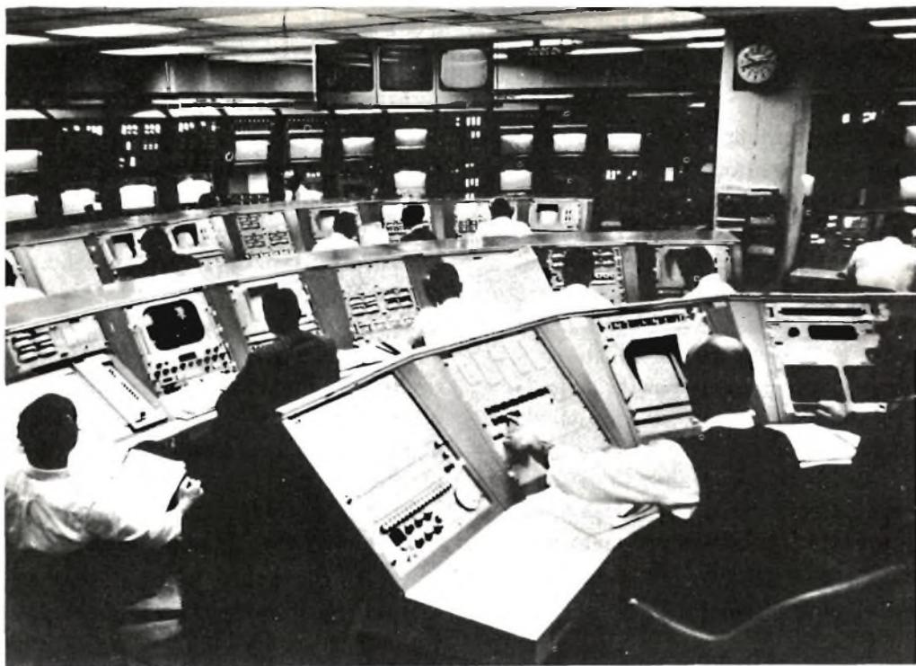
Fig. 1 - Sala Comando di una stazione ACE-S/C, in grado di trattare circa 200.000 segnali al secondo.
