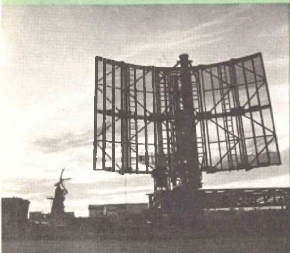
In questo radar tridimensionale a lungo raggio gli strumenti per il rilevamento dei dati sono collocati all'interno della antenna rotante. Il nuovo radar, denominato AR-3D, è in grado di raccogliere informazioni sul raggio d'azione, l'altitudine e l'azimut di qualsiasi oggetto volante e non richiede un'antenna secondaria. La ditta costruttrice è la Plessey.
