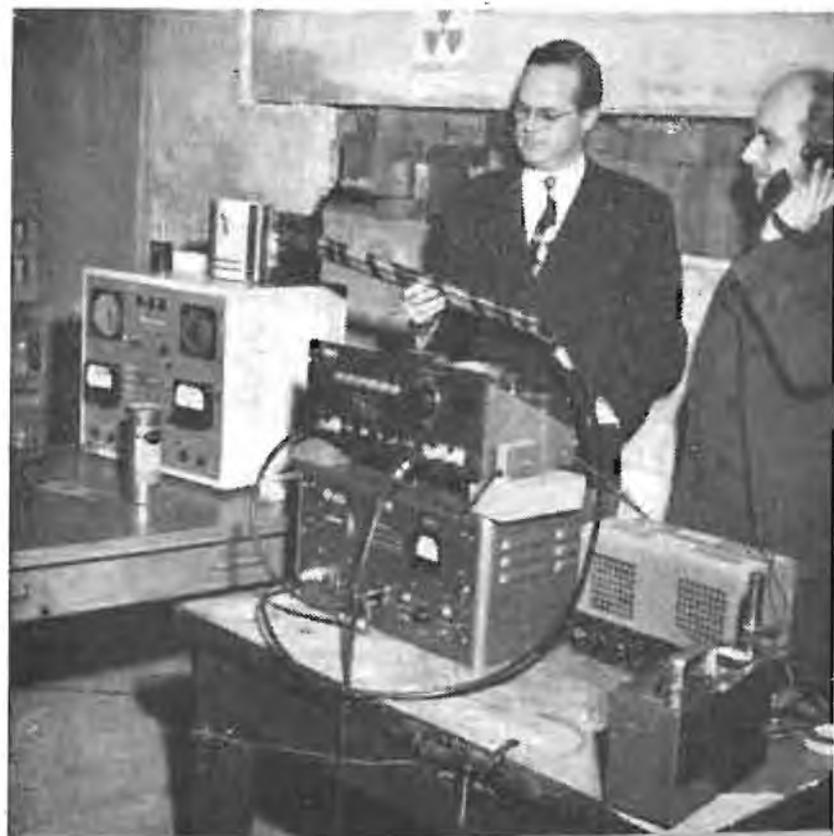
Questo rivelatore di radiazioni con contatore di Geiger viene usato presso la Columbia University dove è stato installato un nuovo Synchro-cyclotrone.
