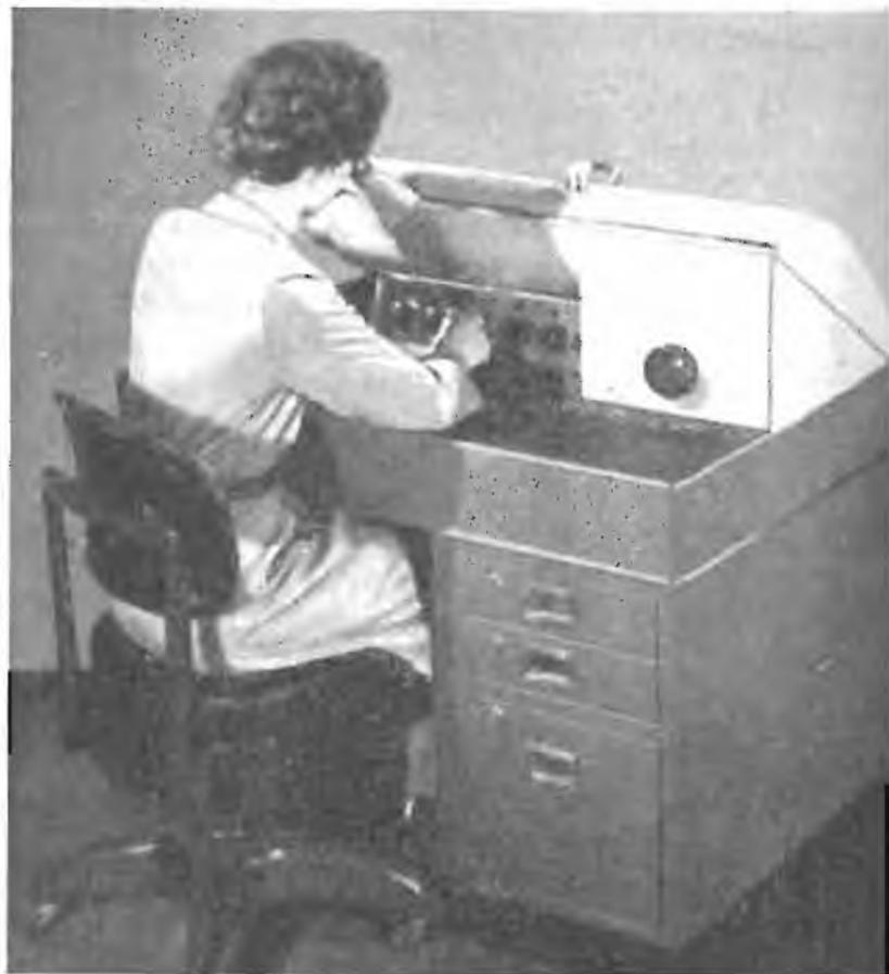
Piccolo microscopio elettronico del tipo elettrostatico di costruzione General Electric particolarmente indicato per i laboratori scientifici e dell'industria.
