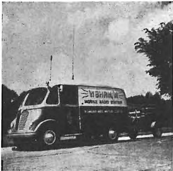
**Organizzazione.** Questo autofurgone appartiene al Milwaukee Radio Amateur Club e contiene una completa apparecchiatura ricevente-trasmittente per le bande radiantistiche dei 2, 10 e 75 metri. Il nominativo di questa stazione mobile è W9HRM/M.
