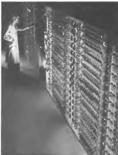
**Presso gli stabilimenti Philips di Eindhoven funziona quest'apparecchiatura che serve a controllare la longevità delle valvole termoioniche.**
