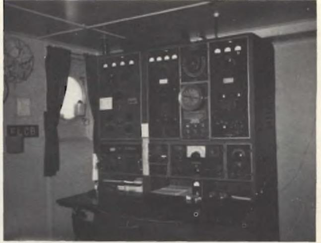
Fig. 5 - Stazione di bordo della Tanker ship «A.N. KEMP», per onde corte e medie, con apparati di emergenza e dispositivo per la trasmissione automatica del segnale di soccorso.
