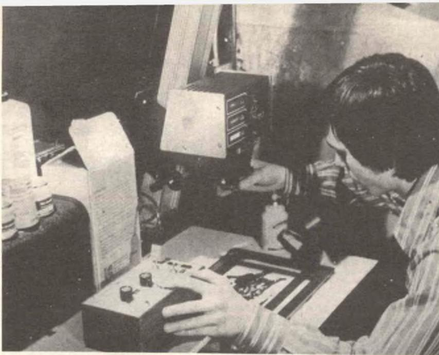
Fig. 24 - La foto mostra un esempio tipico di impiego dell'esposimetro, installato in camera oscura direttamente a portata di mano di chi fa funzionare l'ingranditore.
