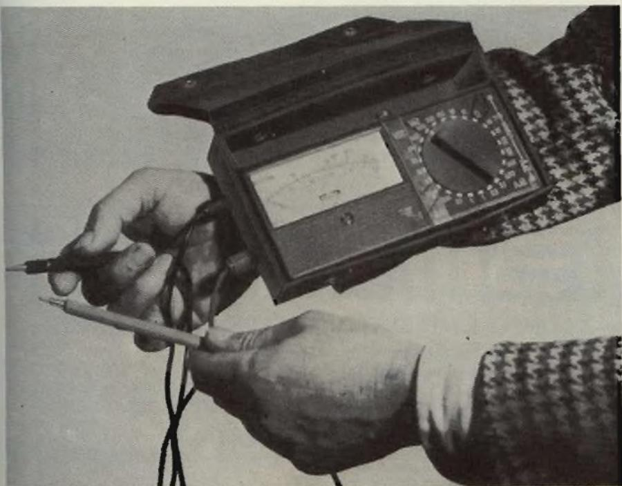
Fig 5 - (in alto) Il modello MX 153 A della Metrix bloccato al polso e in basso con la pinza amperometrica fissata.
