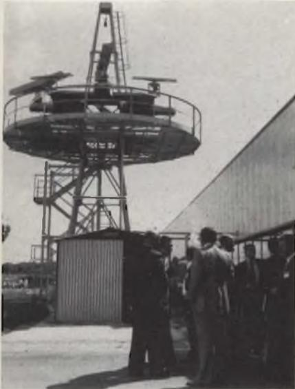
Fig. 20 - Piattaforma sperimentale per il collaudo dei famosi radar della SELENIA (Industrie Elettroniche Italiane, Roma).
