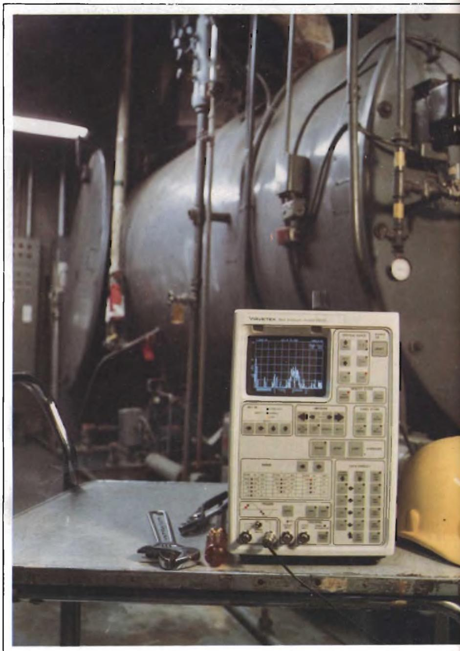
Nel settore della meccanica, quando si vogliono studiare a fondo sorgenti e natura delle vibrazioni, solitamente si impiega un solo dispositivo che trasduce la vibrazione meccanica in una corrispondente tensione elettrica (sensore); in questo caso, il segnale è uno solo, e di conseguenza converrà impiegare un analizzatore di spettro ad un canale.
