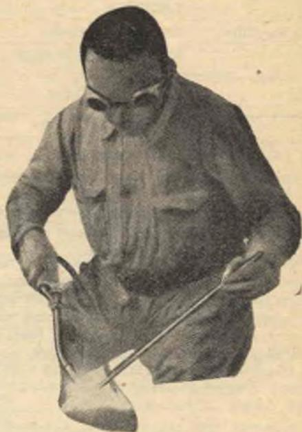
non troppo fluido sostiene la ghisa e facilita molto il compito del saldatore, eliminando altresì per via chimica l'ossido di ferro che si forma durante la saldatura.
