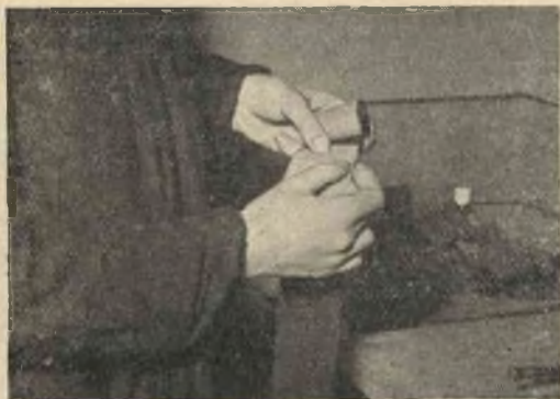
Fig. 1. — Cominciando a svolgere il rotolo ecco dopo una trentina di cm., la pellicola trattenuta da carta gommata. L'operazione va effettuata in camera oscura, con debole luce colorata.
