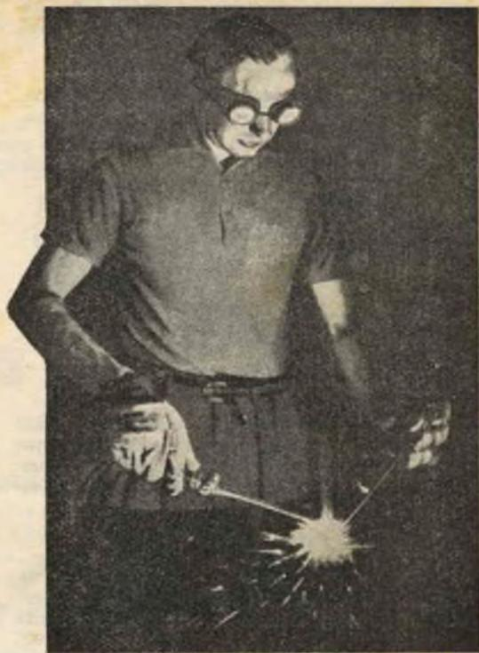
sono seguire due metodi diversi: il primo consiste nell'effettuare un punto di saldatura al centro della connessione delle due lamiere; ciò farà allontanare i due pezzi alle estremità, per effetto della dilatazione causata dal calore della saldatura. Si lascerà quindi raffreddare, finché i due pezzi non saranno ritornati alla posizione di partenza, poi si farà un secondo punto (fig. 1),
