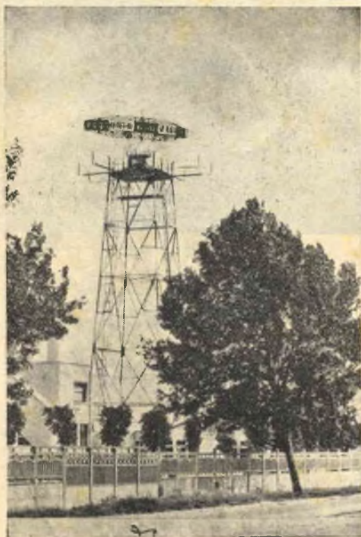
Fig. 2 - Radar terrestre per la sorveglianza a grande distanza. Funziona sulla banda dei 10 cm. e la sua potenza raggiunge i 600 Kilowatt che gli consentono una portata aggirantesi sui 300 Km. Il radar preso in esame risulta installato nel Nord della Francia e viene usato, in tempo di pace, per il controllo del traffico aereo.
