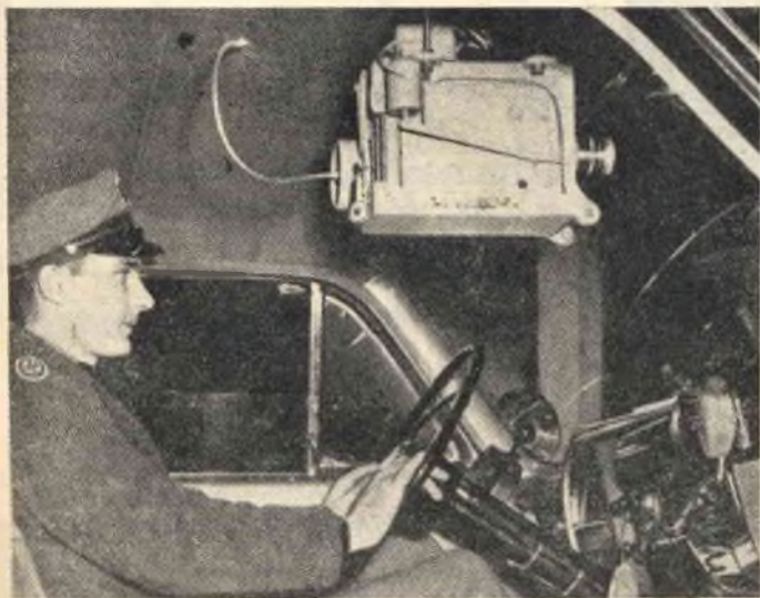
Fig. 1. — Contatore elettronico, per la registrazione delle velocità delle auto, installato sulle vetture della Polizia americana.
