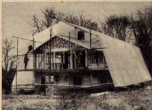
Fig. 4 - Inchiodato su semplici intelaiature in legno, il foglio di polyetilene permette che i lavori di cantiere possano proseguire, grazie alla sua trasparenza, in perfetta luce, proteggendo al tempo stesso uomini e cose dalle probabili intemperie.
